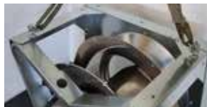
Montage d'œillets de levage aux emplacements dédiés
